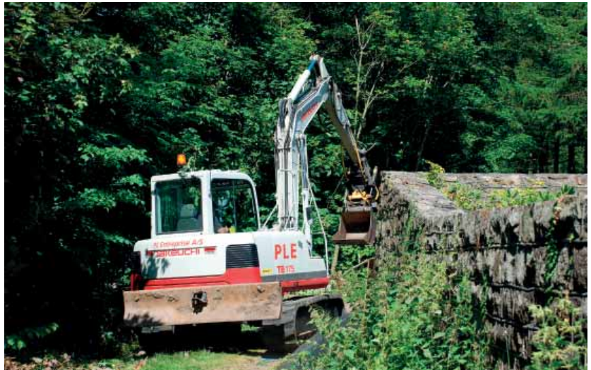
En del af ledningen fra Nexø til Snogebæk løber langs en gammel kirkegårdsmur. Ingen ved på forhånd, hvor meget den kan holde til, så der graves med stor forsigtighed.
