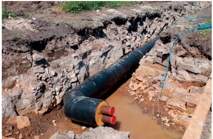
På en stor del af strækningen fra Nexø til Snogebæk gemmer der sig hvid sandsten under jordoverfladen. Sandstenen er meget vanskelig at arbejde med, og det er ikke muligt at måle, hvor den er. Derfor er undergrunden en faktor, der kan påvirke tidsplanen. Foto: Lone Völcker.
