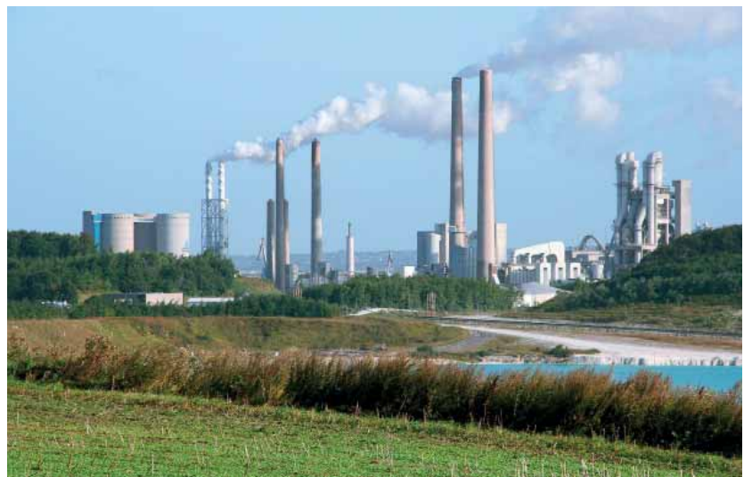
Aalborg Portland er en af virksomheder, der i dag leverer overskudsvarme til fjernvarmenettet. Langt flere danske industrivirksomheder har dog mulighed for at nyttiggøre deres varme. Foto: Aalborg Portland.
