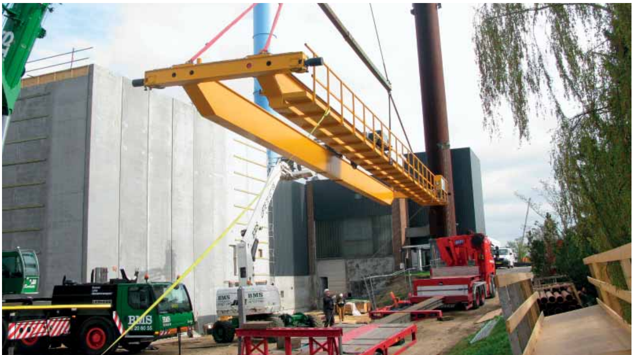
Der har været konstant aktivitet på byggepladsen, mens det nye flisanlæg i Skanderborg er blevet opført. Her er det en del af kranen, der skal løftes på plads i det 900 m 2 store flislager.
