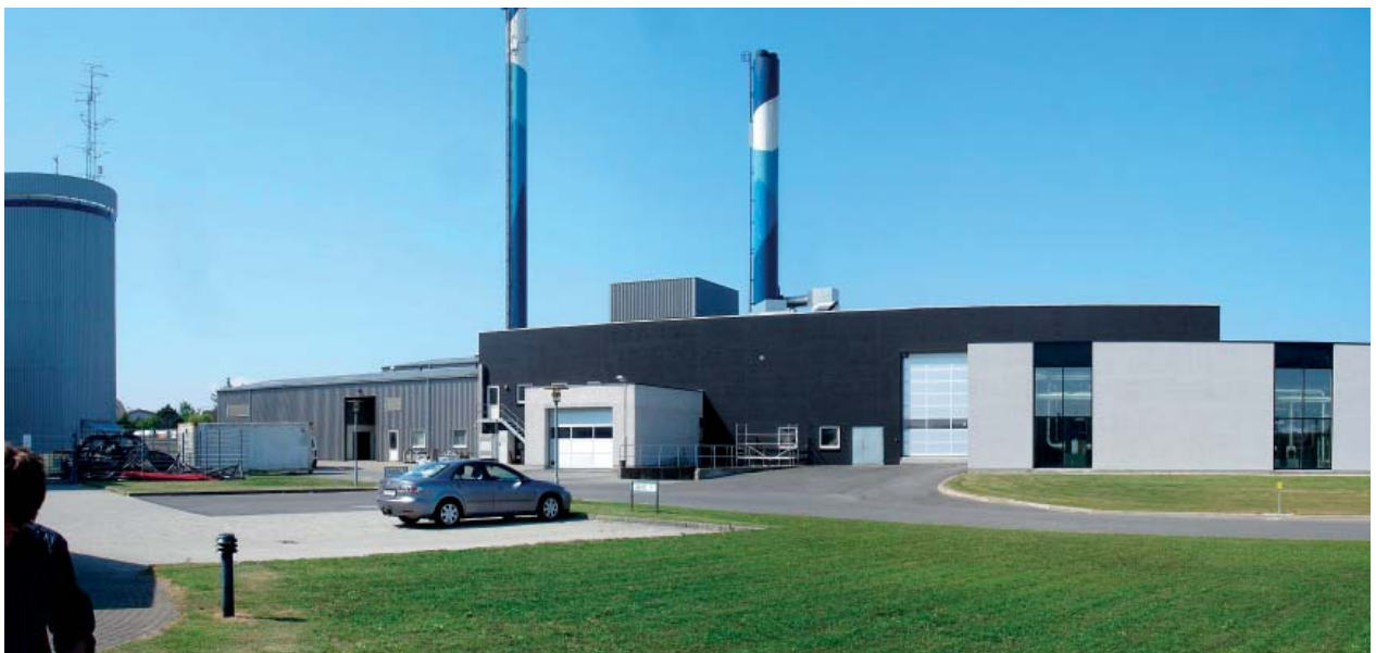
Løgstør Fjernvarmeværk er blandt de fem fjernvarmeværker, der har medvirket i et F&U-projekt, der fokuserer på mulighederne for at optimere ved hjælp af IT.
